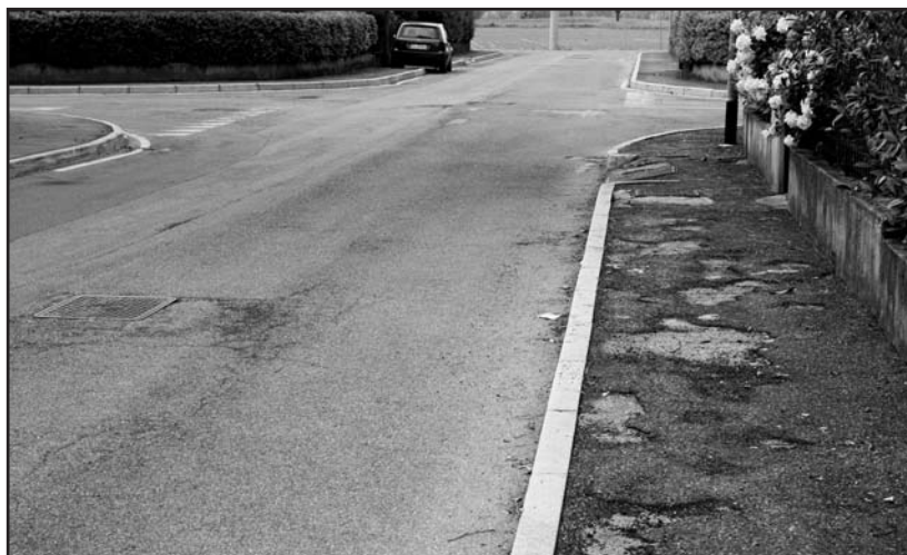
Manto stradale e marciapiedi al villaggio P. Marcolini.
